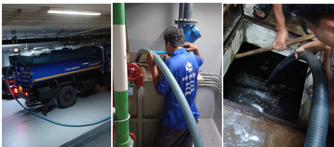
ภาพที่ 2-43 ดูแลรักษาระบบบำบัดน้ำเสีย ดูดตะกอนที่บ่อเก็บตะกอน
