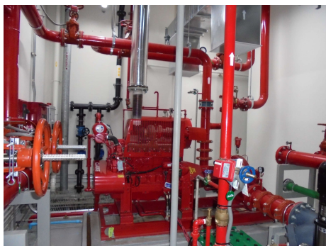
ภาพที่ 2-18 ห้องเครื่องดับเพลิง
